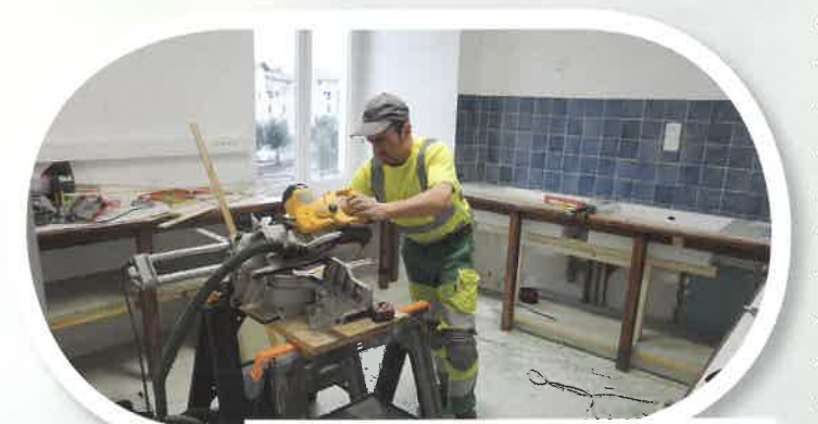
Travaux de menuiseries : aménagement de locaux (placards, paillasses..)
