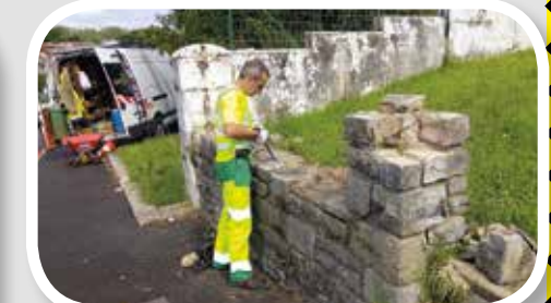
Réparation du mur du calvaire au centre bourg
