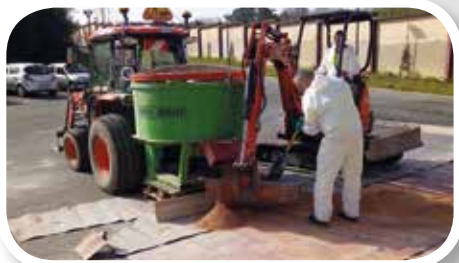
Réfection de la surface du fronton de rebot
