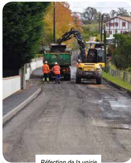
Réfection de la voirie Rue d'Echerouty
