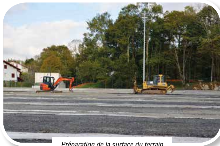
Préparation de la surface du terrain
