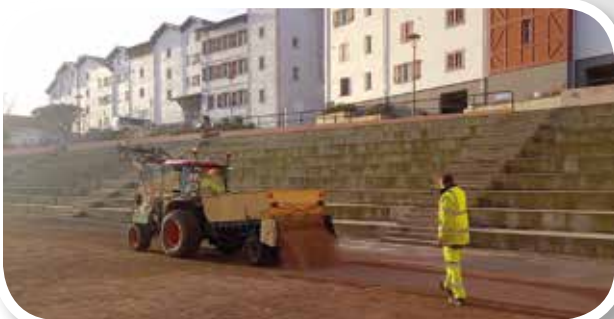
Réfection de la surface du fronton de rebot
