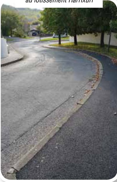
Réfection des trottoirs au lotissement Harrixuri
