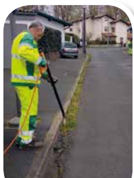
Désherbage de la voirie au brûleur
