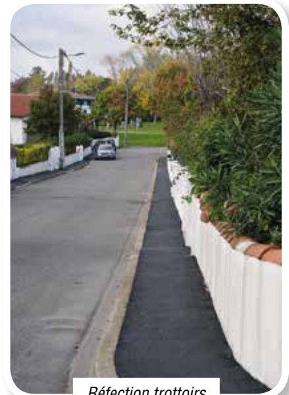
Réfection trottoirs rue Phago Alde
