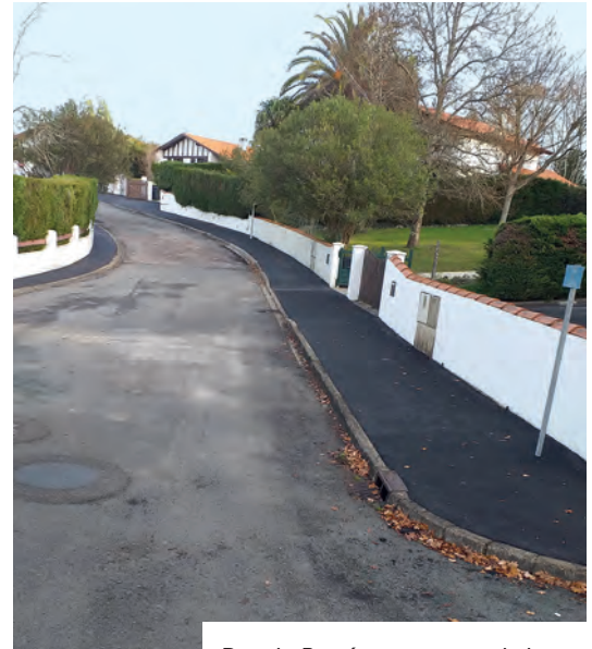
Rue du Basté notamment, de longs travaux liés à la modernisation et à la sécurisation du réseau de gaz
