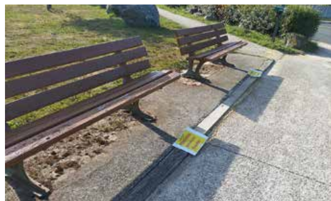
Travaux d'entretien à la Plaine des sports
