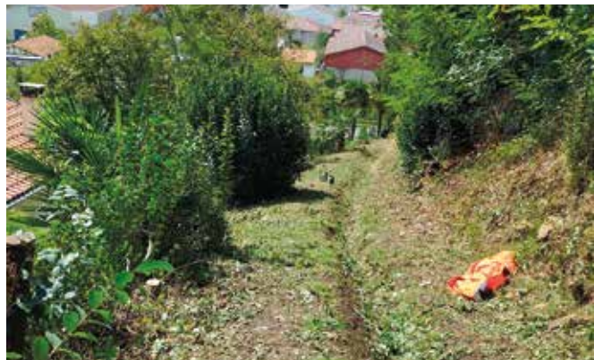
Travaux de déboisement et de nettoyage des rigoles dans le secteur du Chemin de la Forge.
