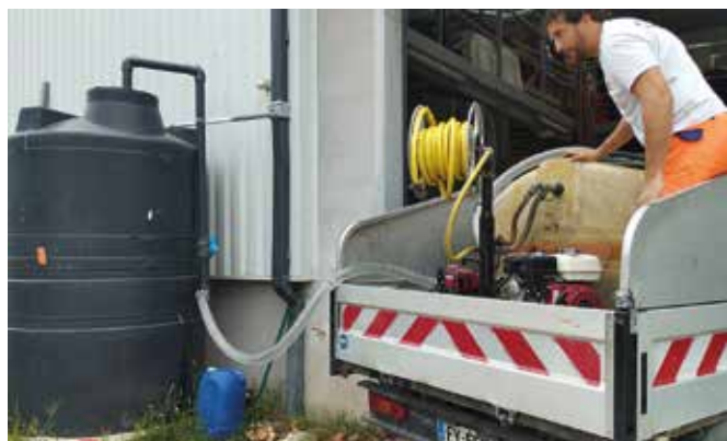
Installation et raccordement de récupérateurs d'eau de pluie, utilisés pour l'arrosage des plantations de la commune.
