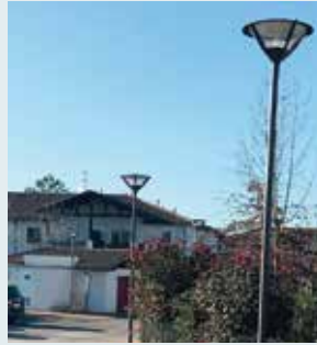
Extinction de l'éclairage sur les espaces publics, de 22h30 à 6h30.
