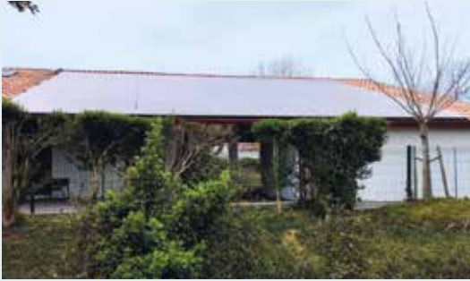
Pose de 84 panneaux photovoltaïques sur le toit de l'école maternelle d'Ourouspoure, qui permettent l'autonomie énergétique de l'ensemble du groupe scolaire.
