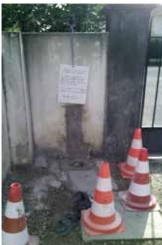
Réparation d'une fuite au cimetière Ur-isurtze baten konpontzea hilerrietan
