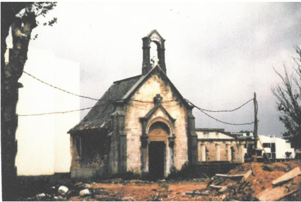
La chapelle de Villa Quieta en 1985 En arrière-plan, l'orangerie en démolition.
