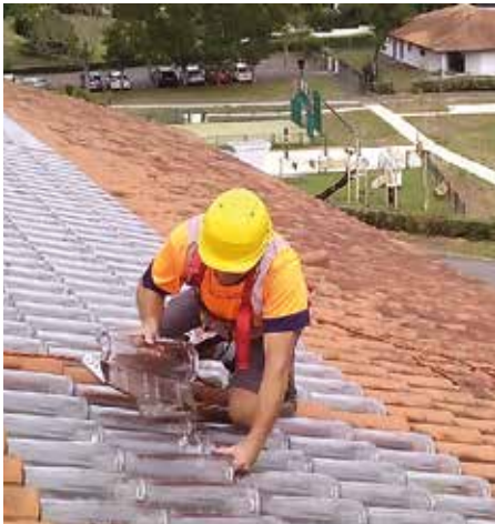
Entretien de la toiture du Mur à gauche
