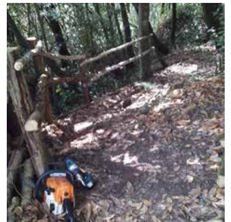
Interventions au sentier de Lissague, dont la création d'une rampe et d'une main courante au sentier du four, avec des matériaux prélevés sur place
