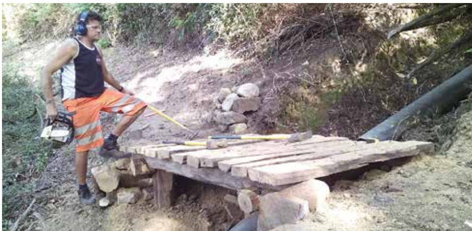
Interventions au sentier de Lissague, dont la création d'une rampe et d'une main courante au sentier du four, avec des matériaux prélevés sur place
