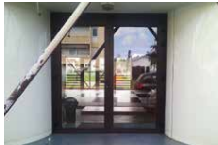
Installation d'une porte d'entrée au Dojo, adaptée aux personnes à mobilité réduite
