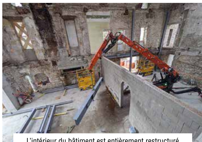
L'intérieur du bâtiment est entièrement restructuré
