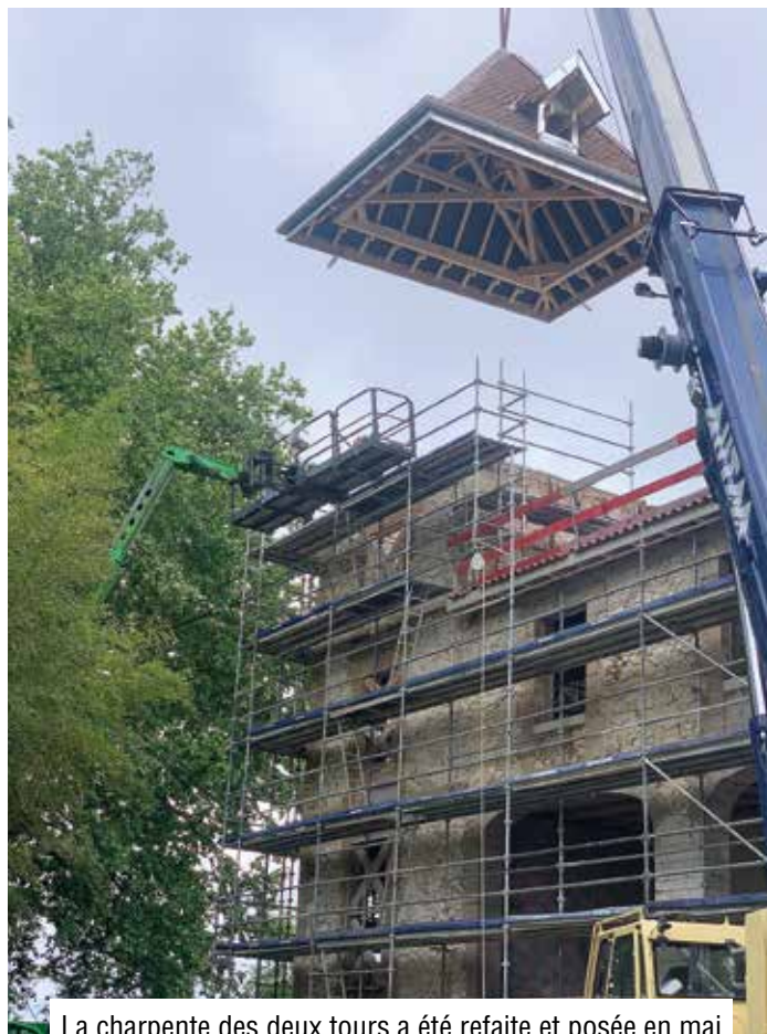
La charpente des deux tours a été refaite et posée en mai
